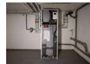
Eine effiziente Heizungsanlage gehört heute in jedes Haus.
