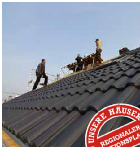
Bei der Dacheindeckung wird auch auf Sturmsicherheit geachtet.
