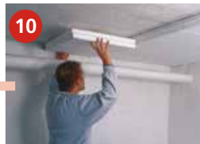
Kelleraußenwände oder die Kellerdecke: 10 Zentimeter dick dämmen.
