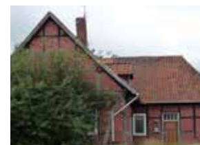
Das Haus von Familie Berger: Im Jahr 2009 ein Sanierungsfall.
