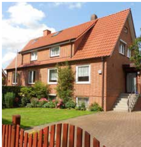
Nach der Modernisierung soll das Haus barrierefrei sein, energieeffizient und sicher.
